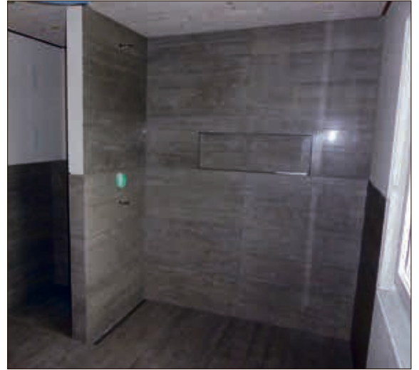
...auf welche dann grossformatige Keramikplatten verlegt wurden.
