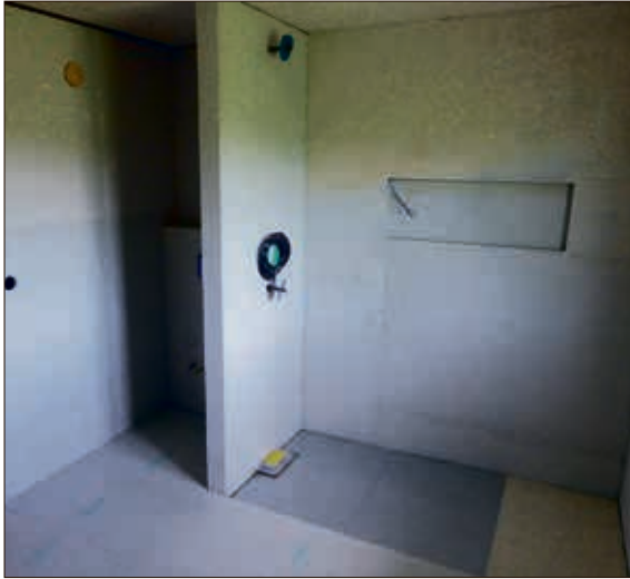
Der Aufbau der Wände wurde im Trockenbausystem erstellt...
