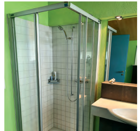
Vor dem Umbau:
