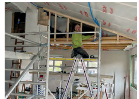
Schreiner-Monteur, Urs Järmann, auf der Baustelle
